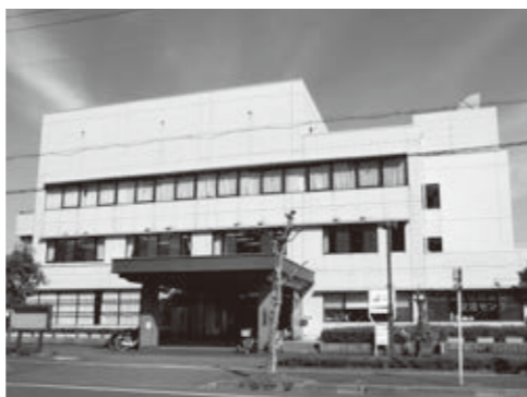
大規模改修工事を予定している今津東コミュニティセンター
