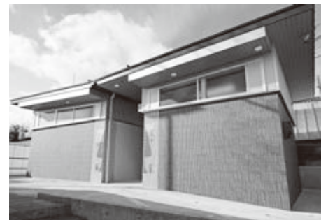
1月に完成したJRマキノ駅前のバリアフリー対応型トイレ
