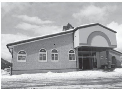
▲愛隣保育園建築現場の状況
