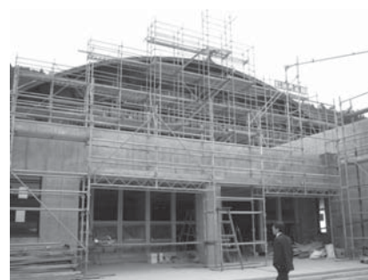
▲朽木小中体育館建築現場の状況
