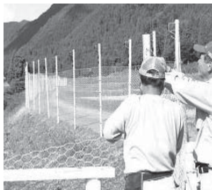
▲集落区民による恒久電気柵設置作業
