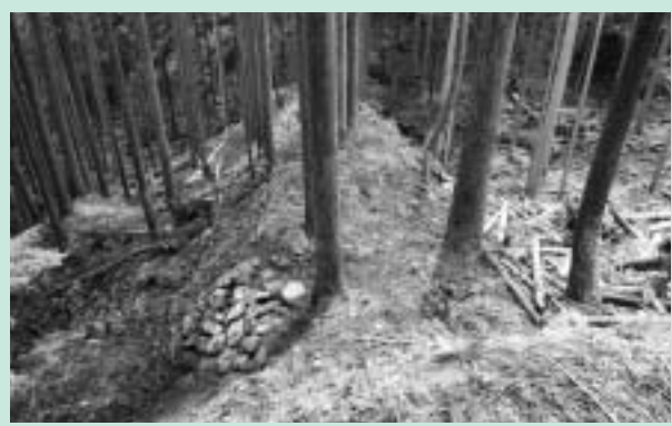
▲岩神堰堤遺跡（手前は洪水吐）
