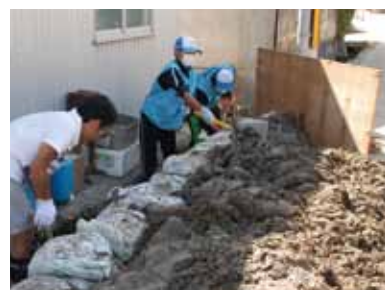
水路の泥出し（南鴨）
