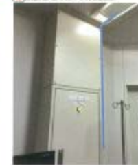
④ 双断面 LANケーブル敷設
