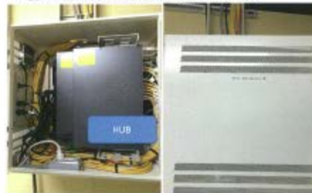
13 EPS内 電子カルテ用ラック内にHUBを設置 (コンセント、1U空き有り)
