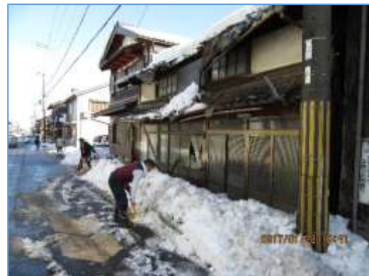
屋根等が崩落し、地域住民が除却する様子(H29年1月)
