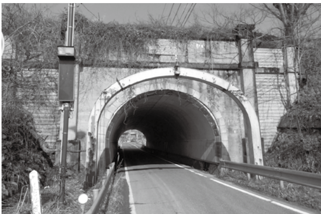
現在の百瀬川隧道
