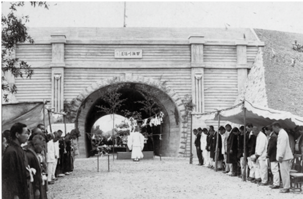
百瀬川隧道竣工式(大正14年7月16日)
