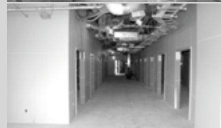
1階の外來待合(写真上)と診察室(写真下)の入口における間仕切り壁や、天井内の設備機器の様子です。
