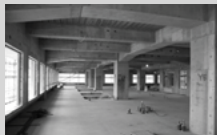
3階の病室部分です。内装工事前はコンクリートの柱と梁だけの広々とした空間です。今後、内装工事が進むと一つの病室の姿が現れてきます。
